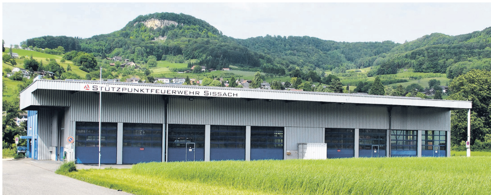
Das Feuerwehrmagazin muss in einigen Bereichen aufgerüstet und erneuert werden.
