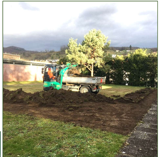
5cm Boden wird mit dem Bagger abgeschält (3.1.2024)
